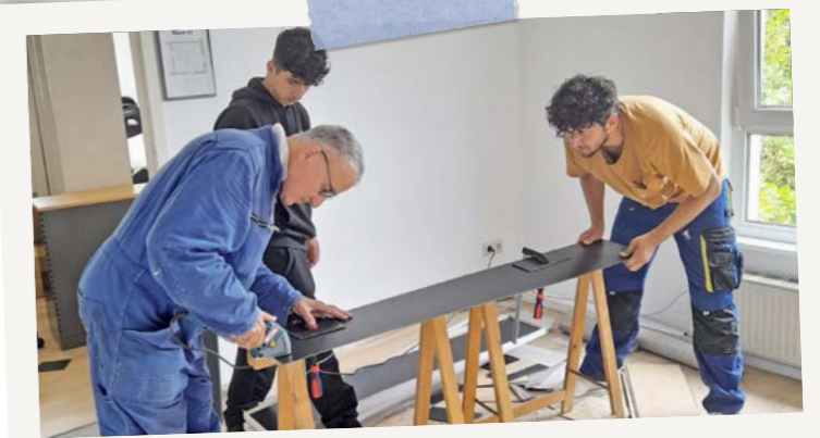
Im gesamten oberen Stockwerk haben wir einen neuen Boden gelegt; – auch hier alles in Eigenregie mit viel Unterstützung von Ehrenamtlichen und Jugendlichen.
