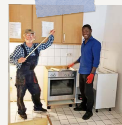
Zuletzt haben wir wieder mit großer ehrenamtlicher Unterstützung die Küche eingebaut!
